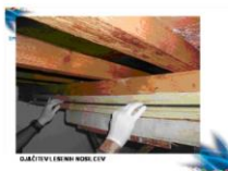
Slika 01: (Ojačitev lesenih nosilcev).
