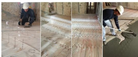
DETAJL B - monolitiziranje stropnikov in sidranje v opečne zidove - HPC.
