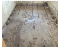
Slika05: Sidranje v opečne zidove
