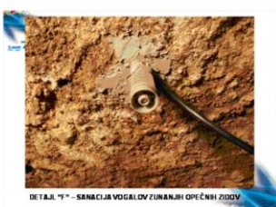
DETAJL "F" - SANACIJA VOGALOV ZUNANJIH OPEČNIH ZIDOV
