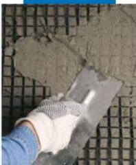
Vgradnja alkalno odporne mreže iz steklenih vlaken Mapegrid G 220 v prvi, sveži sloj malte
